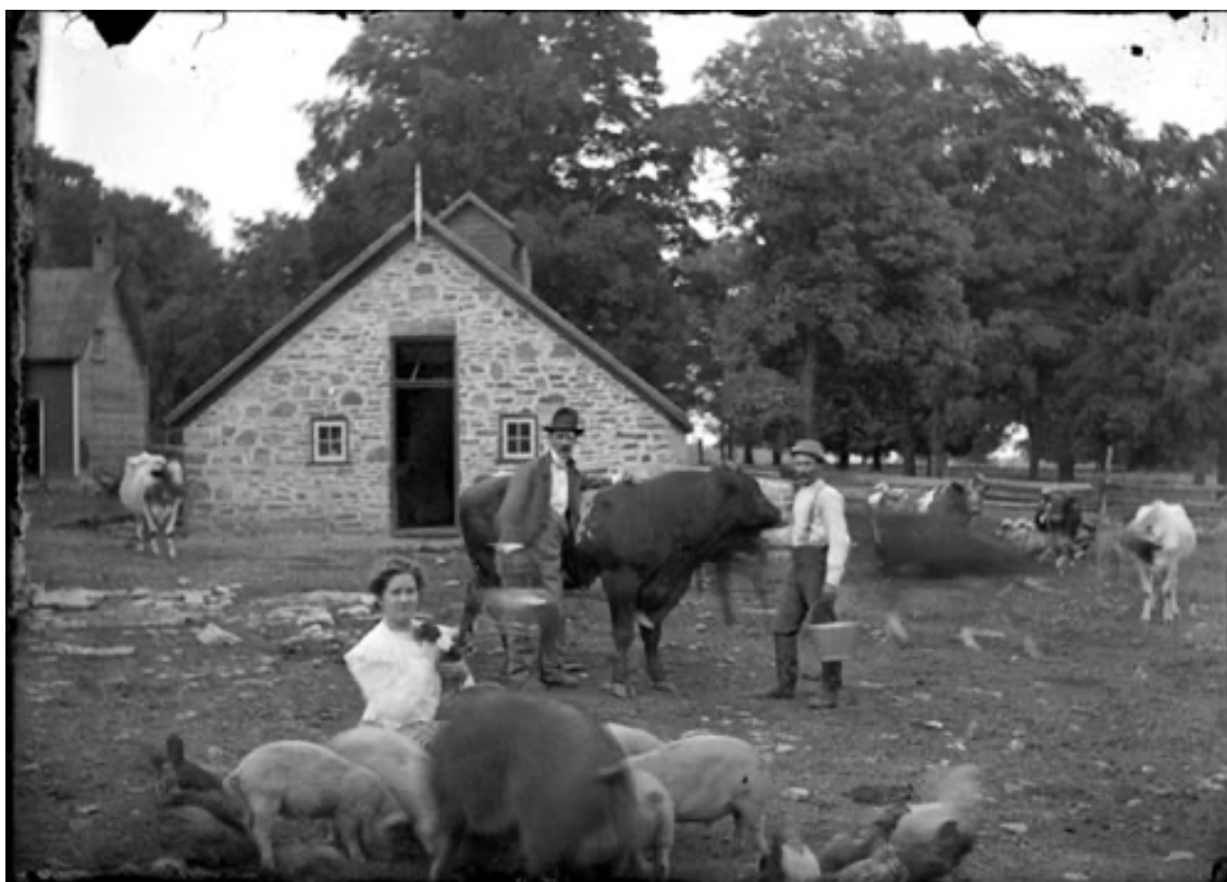
Bâtiment de pierre sur la ferme d'Alexander Macdonell, Black Creek, 1903, C 130-1-0-25-5 Fonds Marsden Kempt
